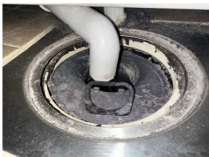
Plastsluk med klemring for membran
