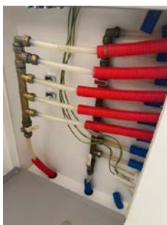
Samleskap med rørkurser og stoppekraner
