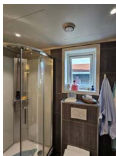
Vindu plassert i våtsone til dusj
