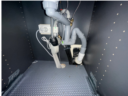
Røropplegg i kjøkkenbenk med Waterguard
