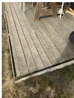
Terrassebord med større slitasje
