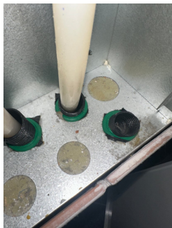
Røropplegg i kjøkkenbenk med Waterguard
