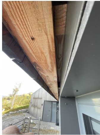
Tett bak kledning. Kledningen er luftet i toppen.
