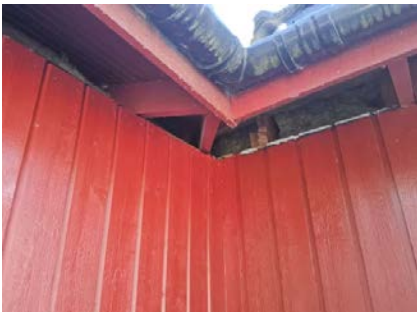
Åpen gessimskonstruksjon med synlig isolasjon fra utsiden.
