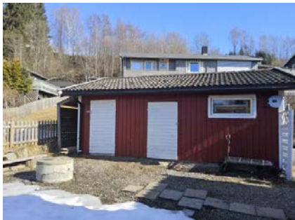
Frittstående garasje med bod.
