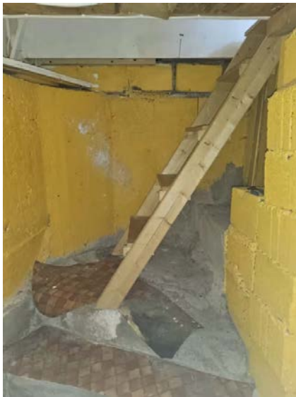
Enkel trapp fra kjeller til 1. etasje.
