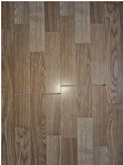
Bilde viser laminatgulv med gliper.
