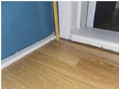
Etasjeskiller er kontrollert med nivelleringslaser.
