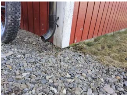
Takrenner og nedløp i metall.
