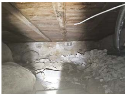
Krypkjeller under deler av boligen.
