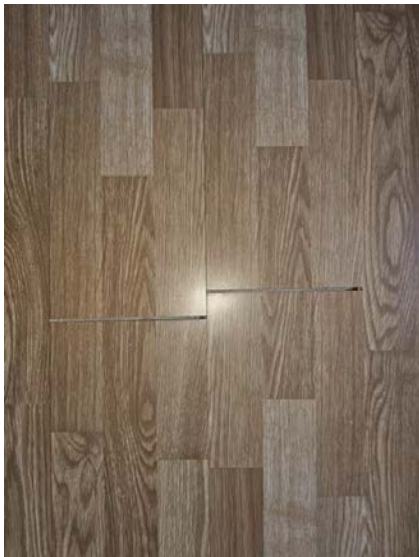
Bilde viser laminatgulv med gliper.
