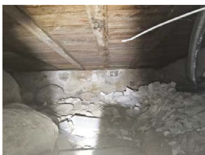
Krypkjeller under deler av boligen.
