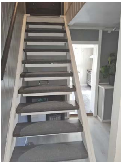
Trapp mellom 1.etasje og loftsetasje.
