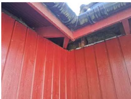
Åpen gessimskonstruksjon med synlig isolasjon fra utsiden.
