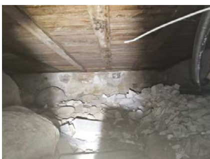
Krypkjeller under deler av boligen.
