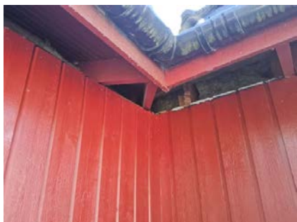
Åpen gessimskonstruksjon med synlig isolasjon fra utsiden.
