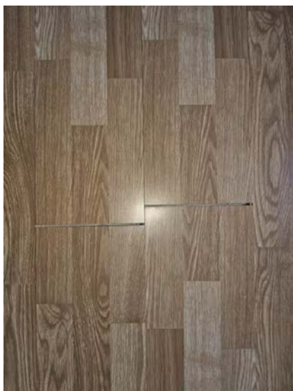
Bilde viser laminatgulv med gliper.
