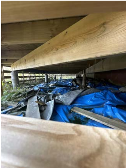
Viser søylefundamenter under terrasse.
