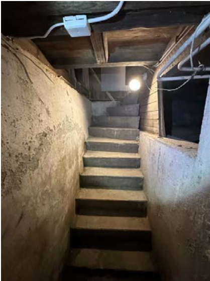
Viser betongtrapp til kjeller.
