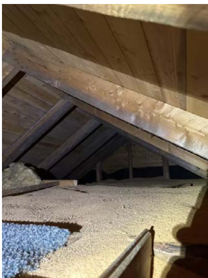
Viser loft isolert med sagflis.
