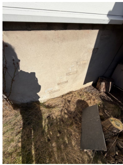
Ikke synlig fuktsikring på utside av mur, sørside.
