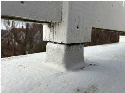
Feste for rekkverk 2 etasje
