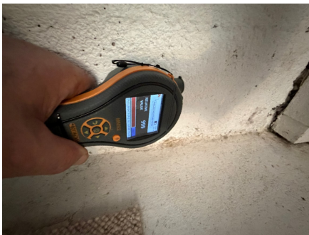
Målt på vegg ved trapp
