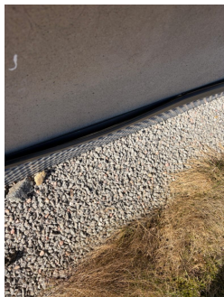
Ikke synlig fuktsikring på utside av mur, sørside.
