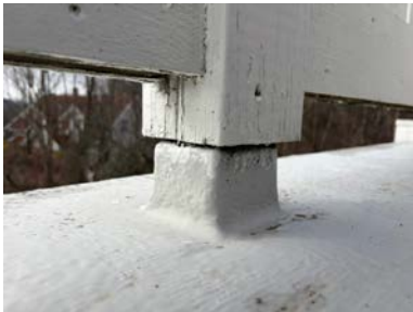
Feste for rekkverk 2 etasje
