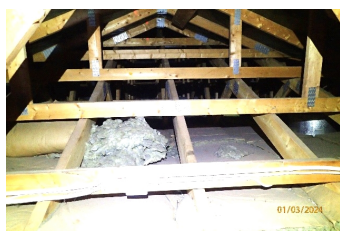
Synlige del av kaldloft fra adkomstluke.
