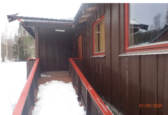
Inngang på baksiden til 1. etasje - adkomst til utleierom og kro/restaurant.
