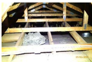
Synlige del av kaldloft fra adkomstluke.
