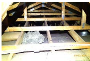
Synlige del av kaldloft fra adkomstluke.
