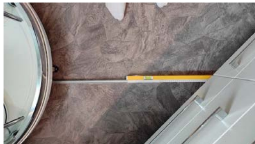
Kontroll av fall.
