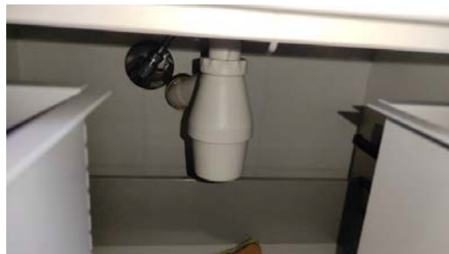
Kontroll av røropplegget.
