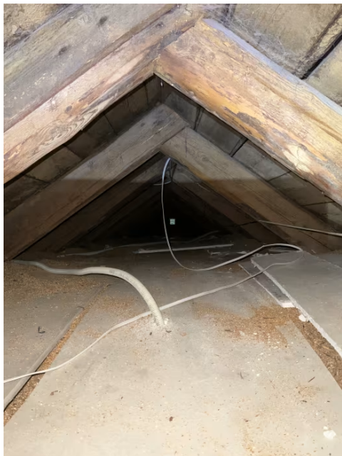
Viser loft med adkomst via luke i himling.
