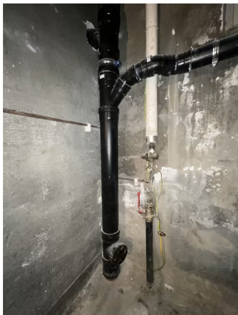
Viser avløpsrør og stakeluke i kjeller.
