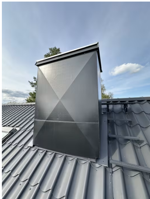
Viser helbeslått pipe over tak.
