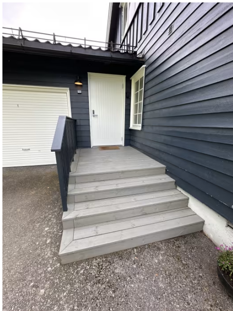
Viser trapp ved inngangsparti.
