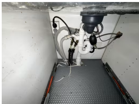
Viser vann og avløpsinstallasjoner under kum.
