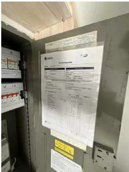
Viser kursfortegnelse ved skap i 2.etasje
