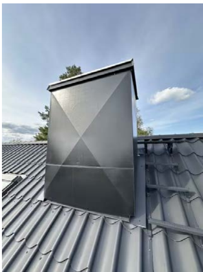
Viser helbeslått pipe over tak.
