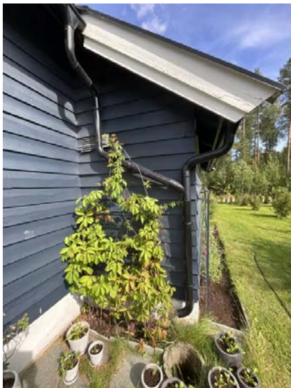
Det anbefales å snu utkast ved nedløpsrør og etablere drensør på utkast.
