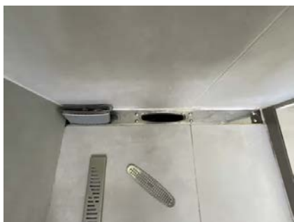
Viser sluk i dusjsjonen.
