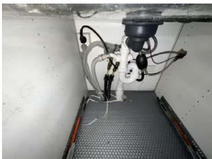
Viser vann og avløpsinstallasjoner under kum.
