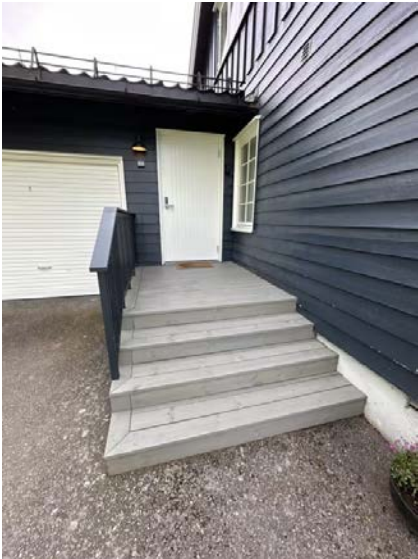
Viser trapp ved inngangsparti.
