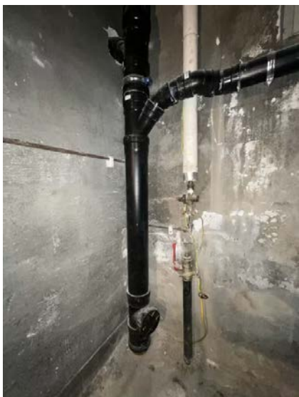
Viser avløpsrør og stakeluke i kjeller.
