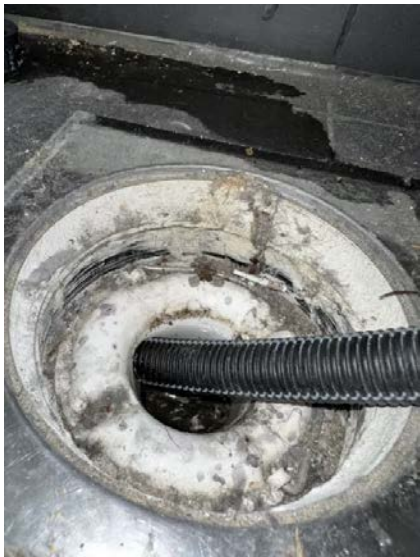
Pga flislim er det ikke mulig å fullverdig kontrollere klemring eller bruk av membran.
