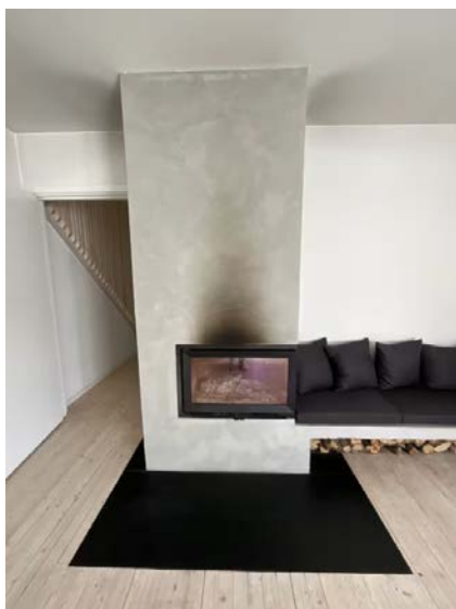
Viser ildsted plassert i stue 1.etasje
