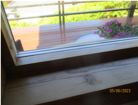
Punkttert vindu i gavl
