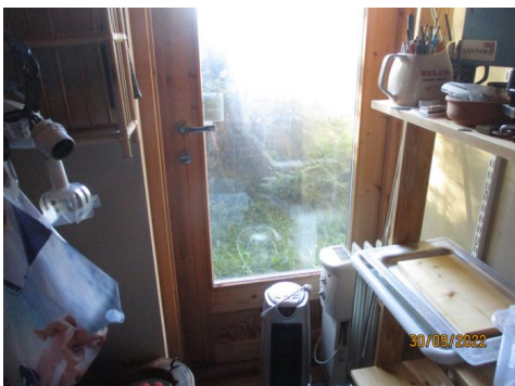
Punkttert vindu i dør, kjeller
