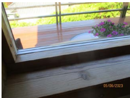
Punkttert vindu i gavl
