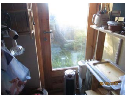
Punkttert vindu i dør, kjeller
