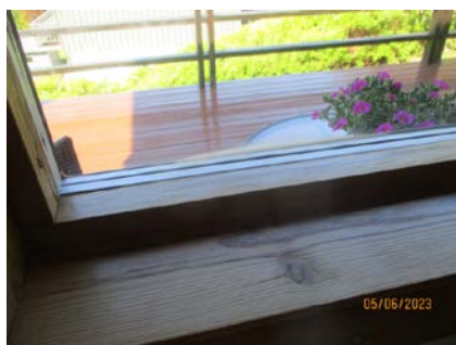
Punkttert vindu i gavl
