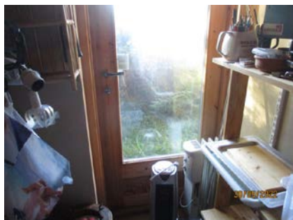
Punkttert vindu i dør, kjeller
