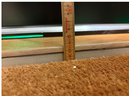
Oppkant under ytterdør 25mm
