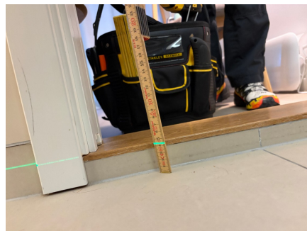
Oppkant under dør til soverom 35mm
