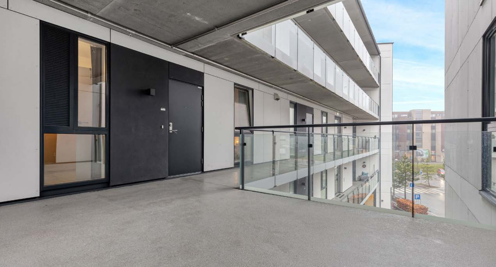
Leiligheten ligger i byggets 3.etasje og har adkomst fra svalgang.
