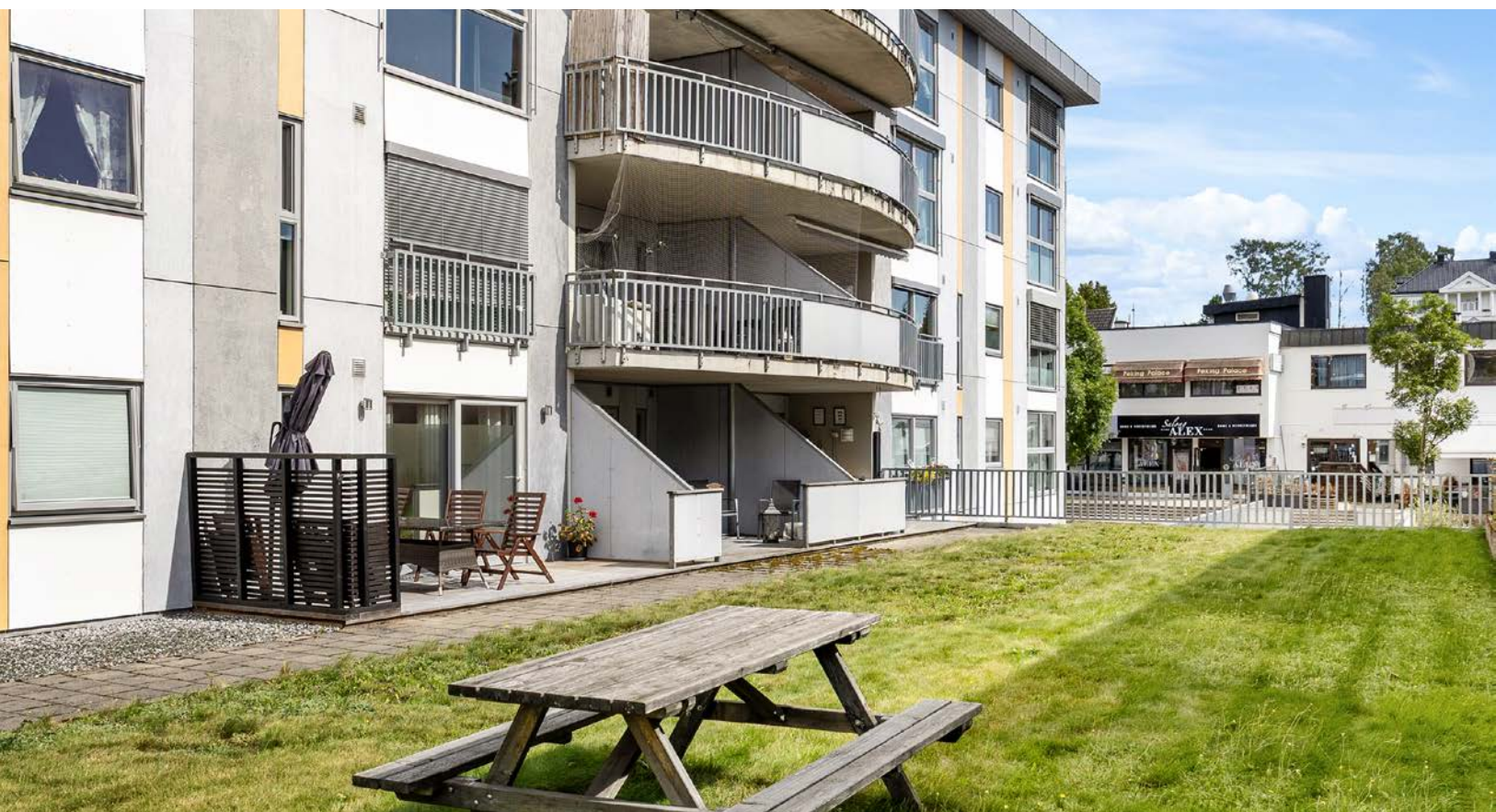
Fasade Høvlerigata 2. Fine fellesområder opparbeidet med plen.
