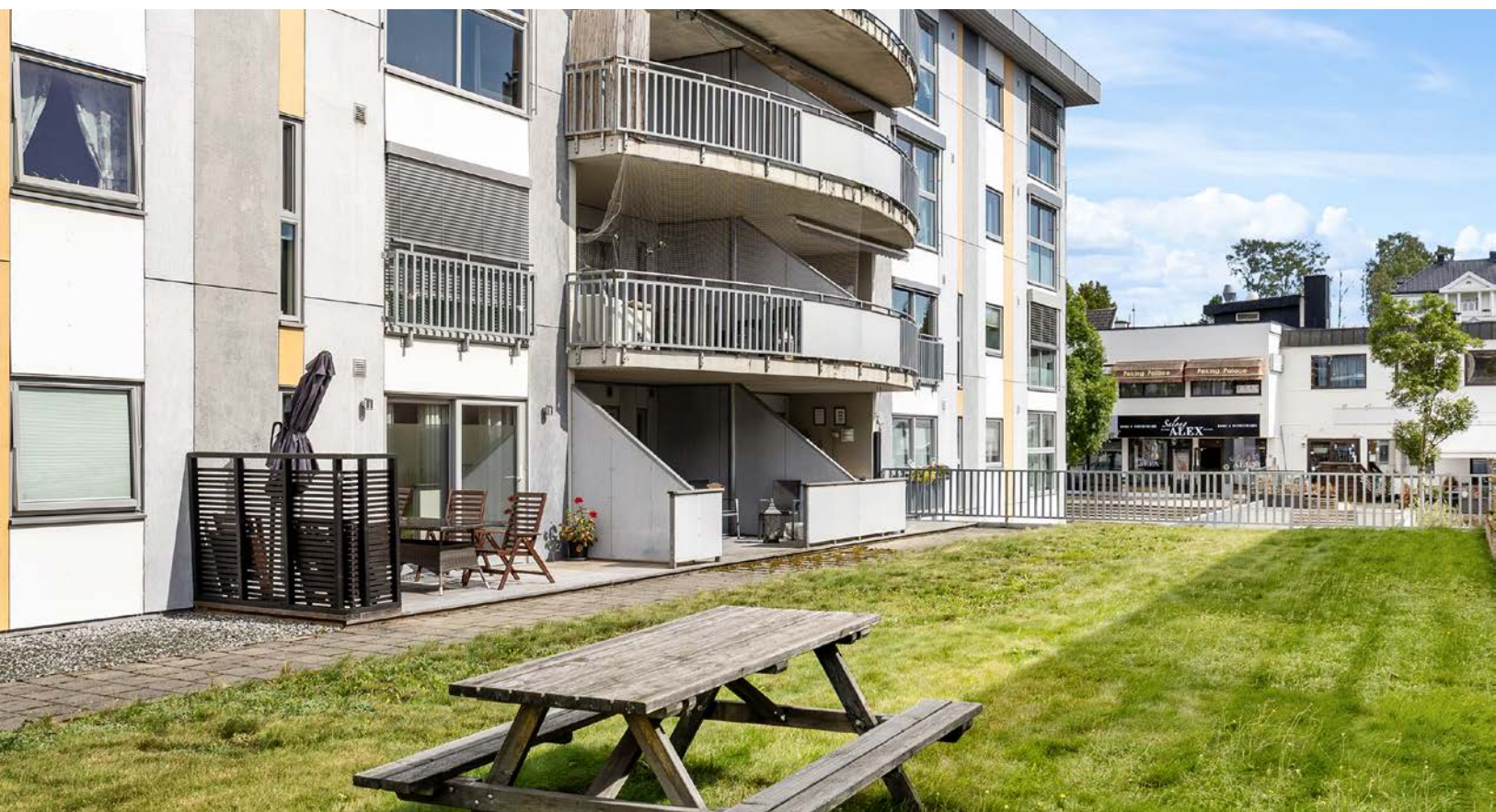
Fasade Høvlerigata 2. Fine fellesområder opparbeidet med plen.
