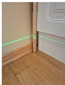
Målt fra 8,1 cm mot yttervegg...
