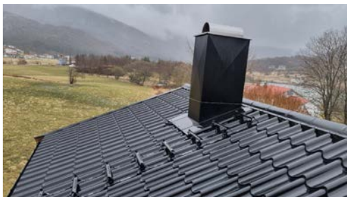
Besiktigelse av taktekke.
