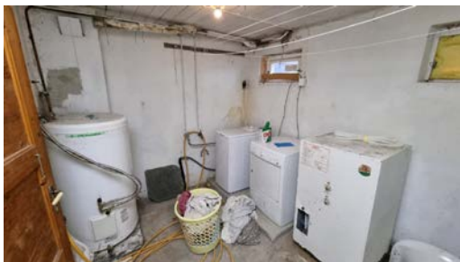
Vaskerommet er et grovkjellerrom.
