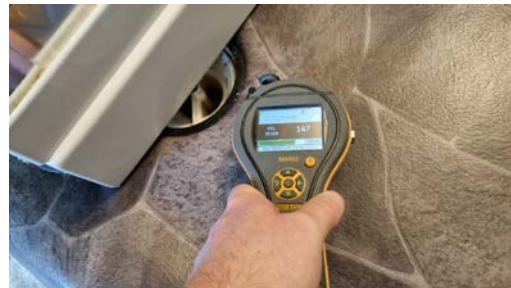
Kontroll av sluk og fuktmåling. Ingen forhøyde fuktverdier ble registrert.
