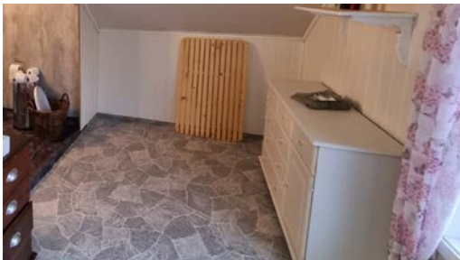
Gulvbelegget i denne delen er ikke godkjent for bruk i våtrom.
