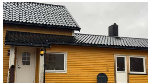
Besiktigelse av taktekke.
