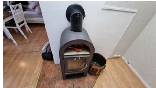
Kontroll av ildsted.
