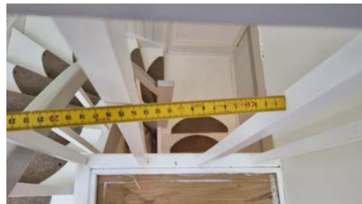
Kontroll av åpninger i rekkverk.
