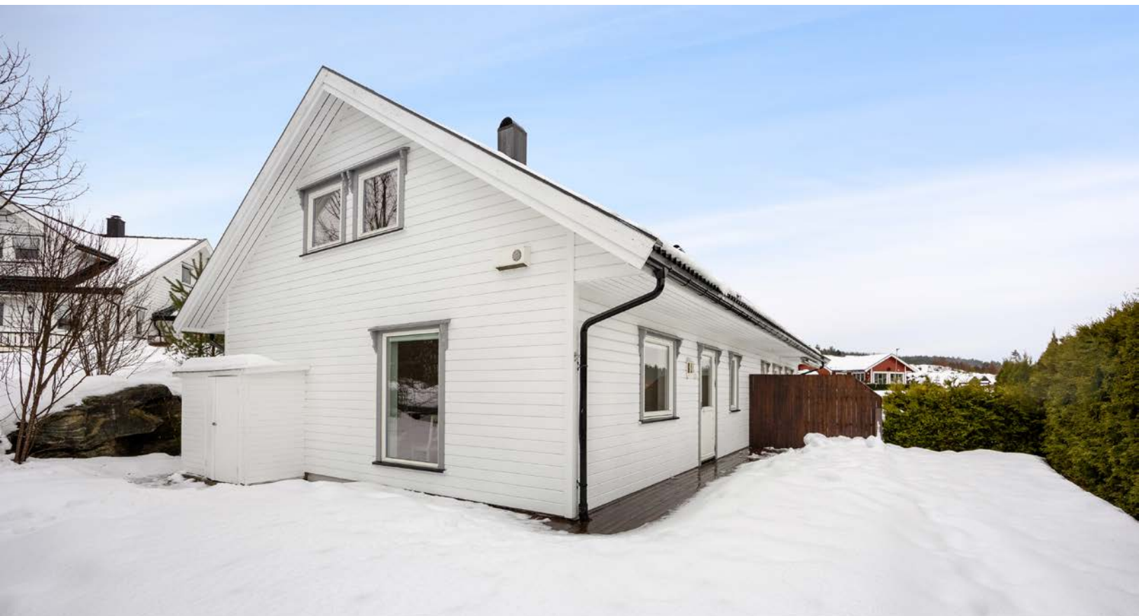
Eiendommen ligger i et rolig og barnevennlig område i Vestrengåsen på Moe, cirka 4 km utenfor Løken sentrum.
