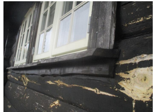
Nyere vinduer i stue.
