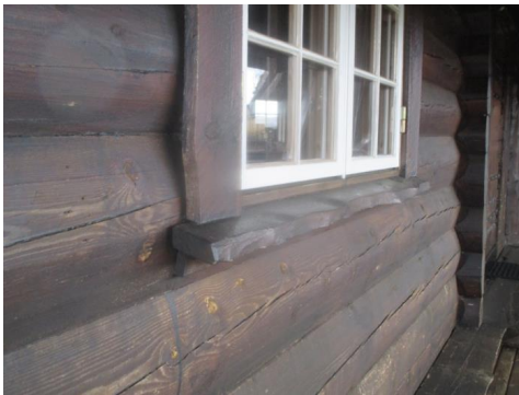
Deler av tømmervegg med tilhørende belistninger.
