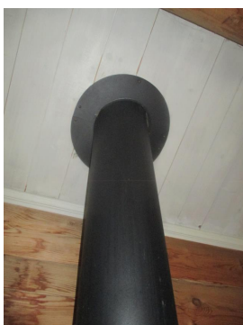
Takgjennomføring av ene pipe.
