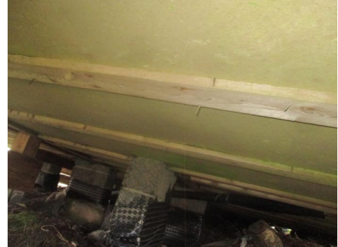
Deler av fundamenteringen under hytta.
