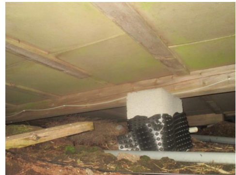
Underliggende drager for bjelkelaget.
