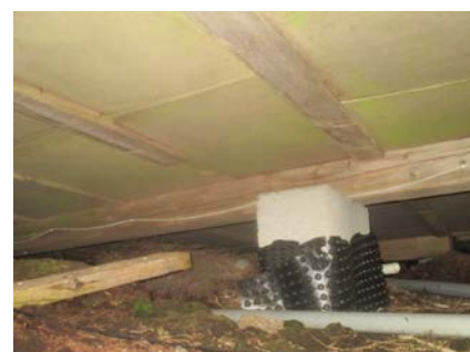
Underliggende drager for bjelkelaget.
