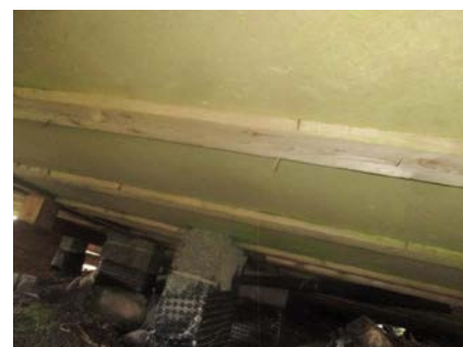
Deler av fundamenteringen under hytta.
