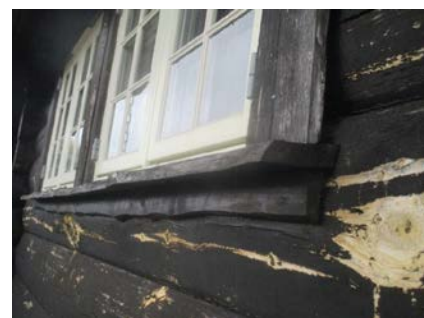
Nyere vinduer i stue.
