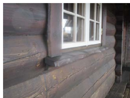
Deler av tømmervegg med tilhørende belistninger.
