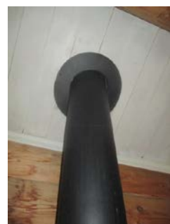
Takgjennomføring av ene pipe.
