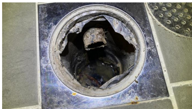
Kontroll av sluk.
