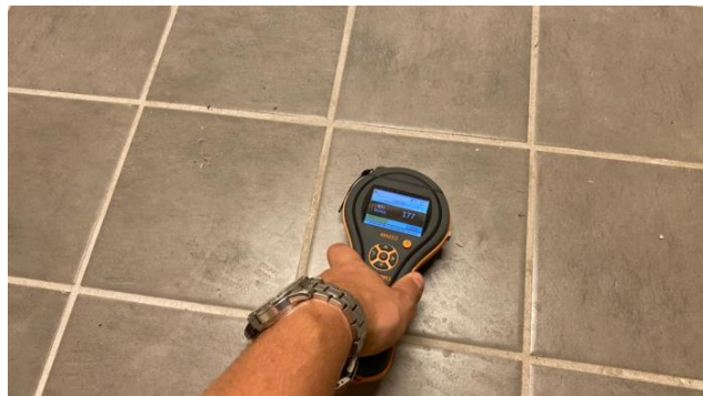
Fuktmåling i gulvet.
