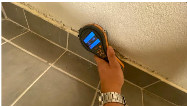
Fuktmåling i vegg.
