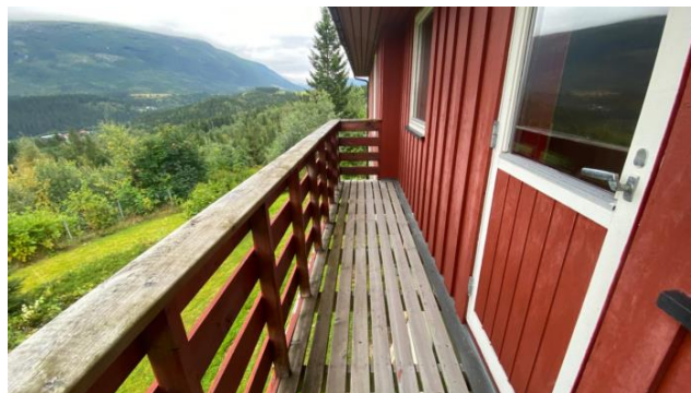
Balkongen er oppført utenfor fasade øst.
