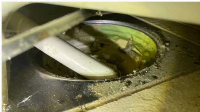
Kontroll av sluk.
