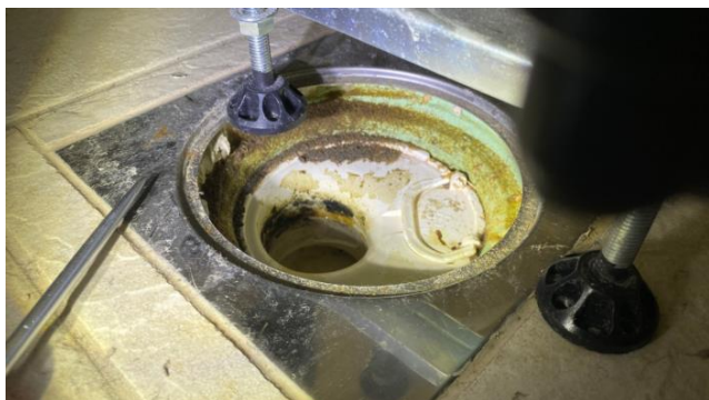
Kontroll av sluk.
