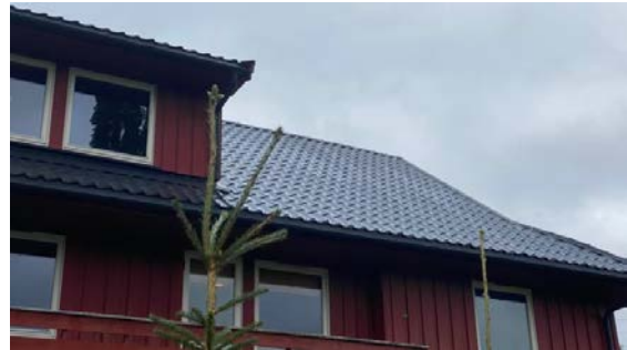
Visuell besiktelse av taket.
