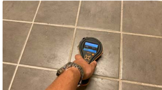
Fuktmåling i gulvet.
