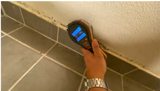
Fuktmåling i vegg.
