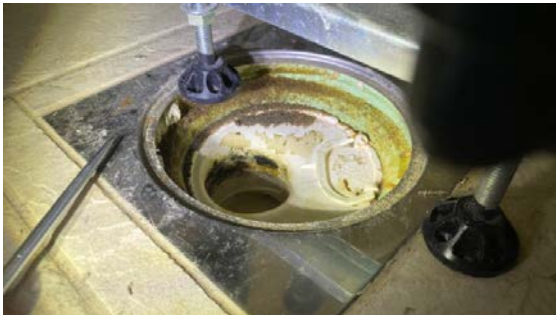
Kontroll av sluk.
