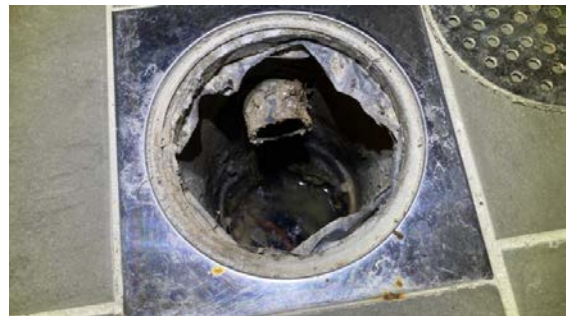
Kontroll av sluk.
