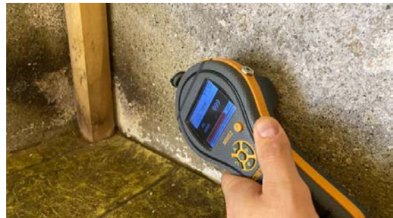
Fuktmåling i yttervegg i sokkeletasjen.
