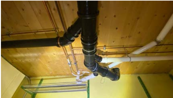
Kontroll av røropplegg i sokkeletasjen.
