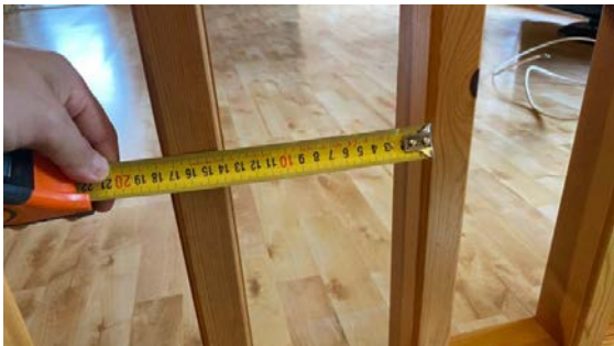
Måling av lysåpninger i rekkverket i loftsetasjen.
