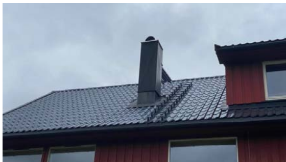
Visuell besiktelse av taket.
