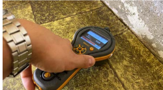
Fuktmåling i gulv i sokkeletasjen.
