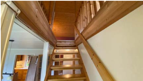
Trapp mellom hovedetasje og loftsetasje.
