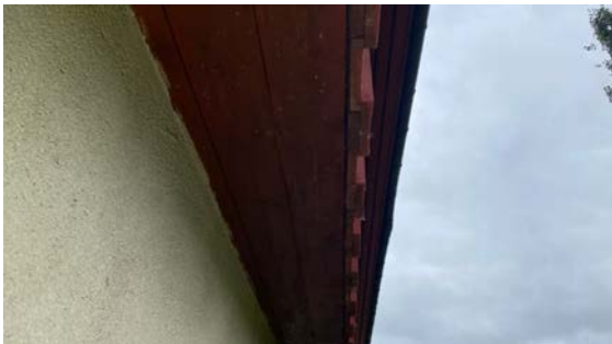
Kontroll av ytterkledningen.
