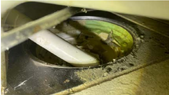
Kontroll av sluk.
