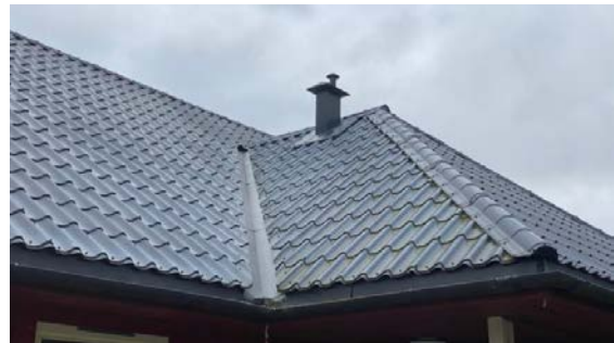
Visuell besiktelse av taket.
