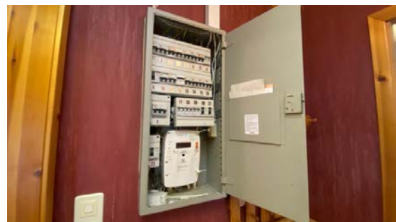
Kontroll av el-skapet.
