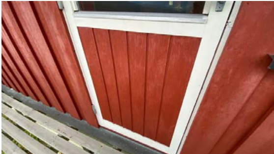
Terrassedør på soverommet.
