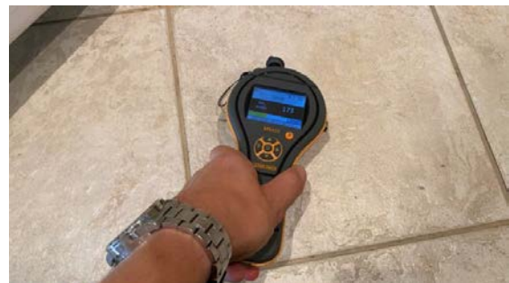
Fuktmåling i gulvet.
