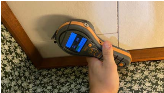
Fuktmåling i himling, ingen unormale fuktverdier ble registrert.
