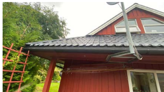
Visuell besiktelse av taket.
