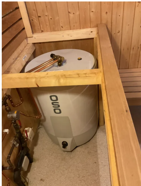
Varmtvannsbereder.
