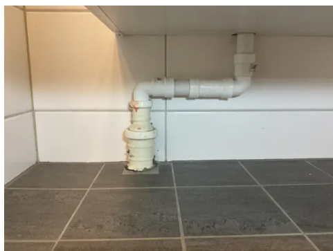
Avløpsrør på bad.
