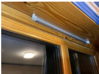
Ventil i vindu.
