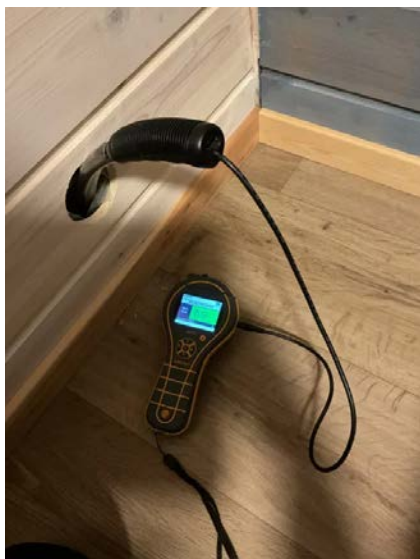
Hulltaking i vegg under terreng.
