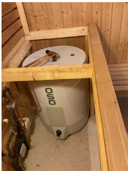
Varmtvnsbereder.
