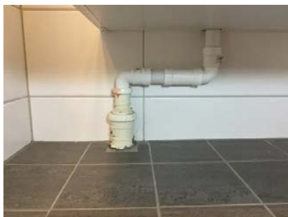
Avløpsrør på bad.
