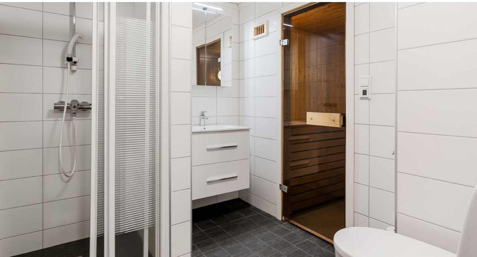
Flislagt baderom som ble rehabilitert i 2020 og innredet med dusjnise, servant på innredning og toalett.
