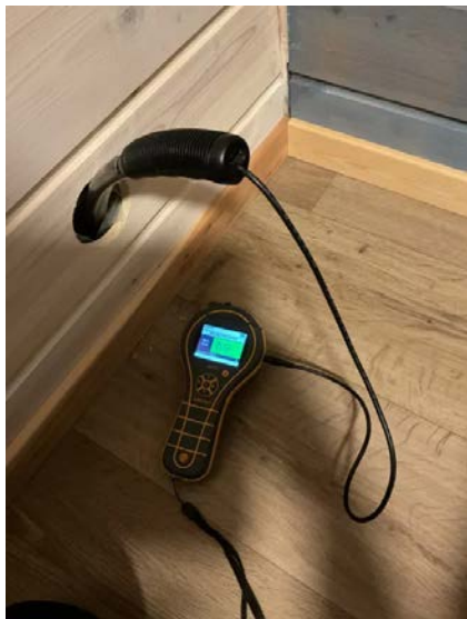
Hulltaking i vegg under terreng.
