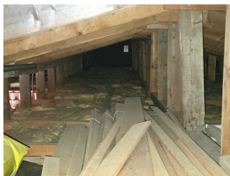
Nedbøyning i takkonstruksjon.
