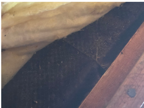
Svartpapp mellom himling og isolasjon.
