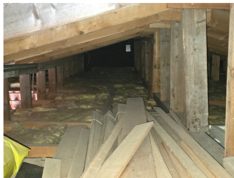
Nedbøyning i takkonstruksjon.
