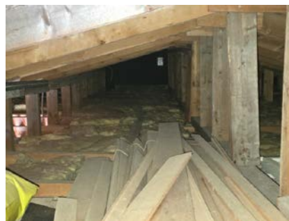
Nedbøyning i takkonstruksjon.
