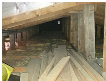
Nedbøyning i takkonstruksjon.
