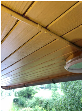
Bildet viser vannråper fra himling utenfor inngangsparti
