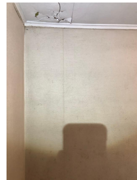
Bilde fra himling på soverommet i underetasjen.
