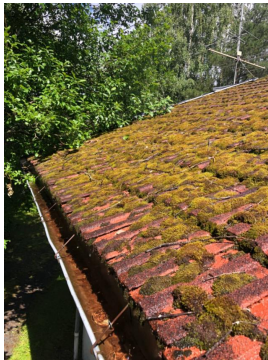
Bilde av takrenne over inngangsparti
