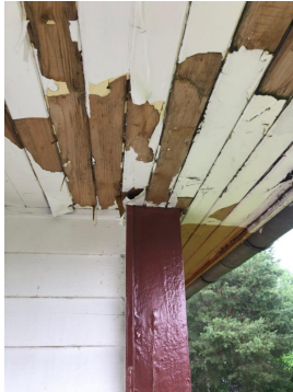
Bilde av himling over inntrukket balkong
