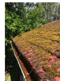
Bilde av takrenne over inngangsparti
