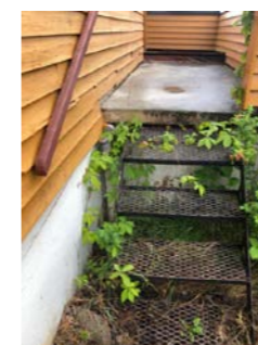
Bilde av trapp opp til balkong
