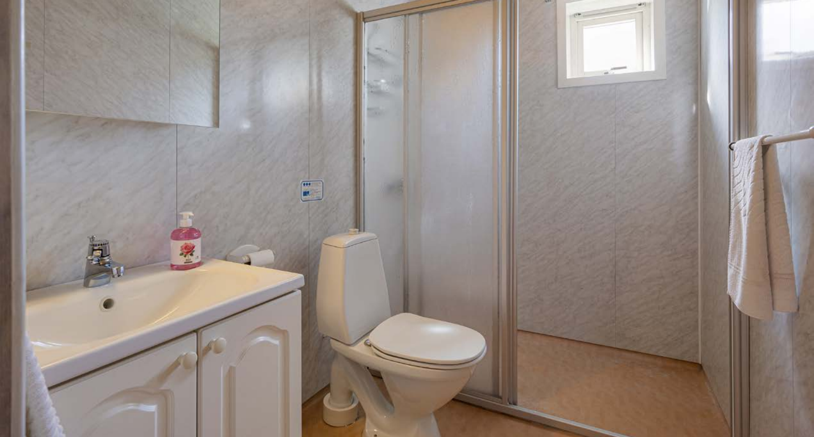
Badet i sokkeletasjen har lyse våtromsplater på veggene, panel i himlingen og beige belegg på gulv med gulvvarme. Hvit skapseksjon med heldekkende servant, samt speilskap med belysning. I tillegg toalett og dusjnise bak en frostet skyvedør.
