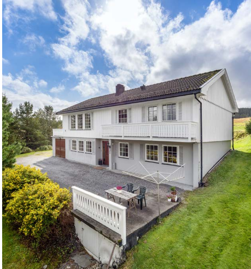
Det er en støpt uteplass i forbindelse med dengruslagte gårdsplassen.
