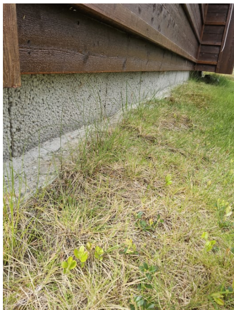
Bilde viser grunnmursstripe.
