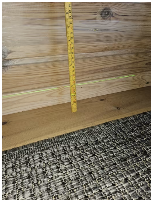
Bilde viser måling av etasjeskiller.
