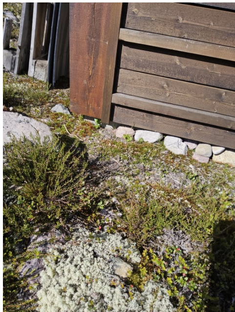
Bilde viser kledning ført ned mot terreng.
