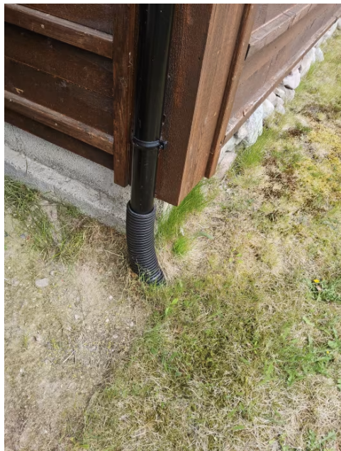
Bilde viser taknedløp ført ned i drensrør.
