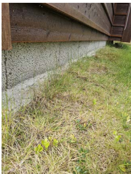
Bilde viser grunnmursstripe.
