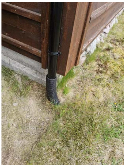
Bilde viser taknedløp ført ned i drensrør.
