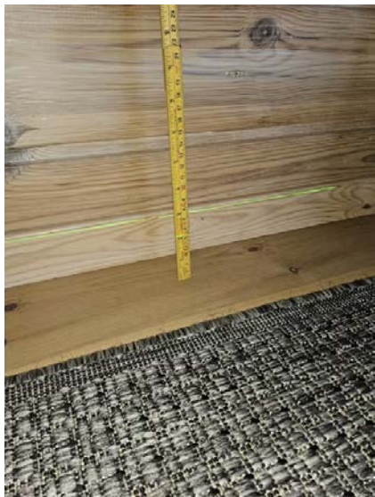
Bilde viser måling av etasjeskiller.
