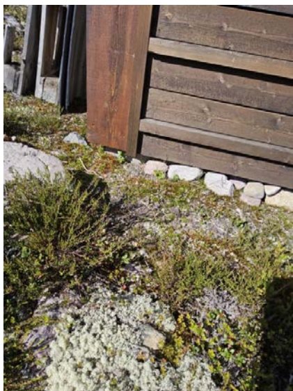
Bilde viser kledning ført ned mot terreng.
