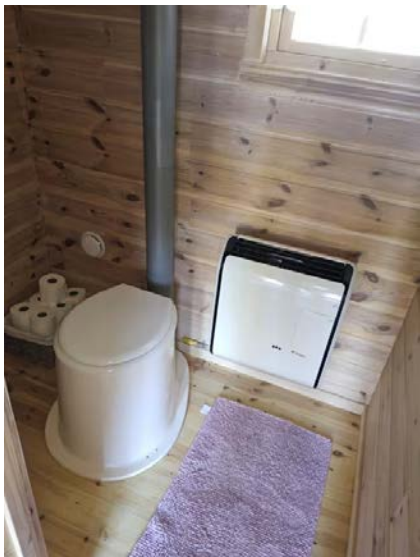
Bilde viser toalettrom med mulldo.
