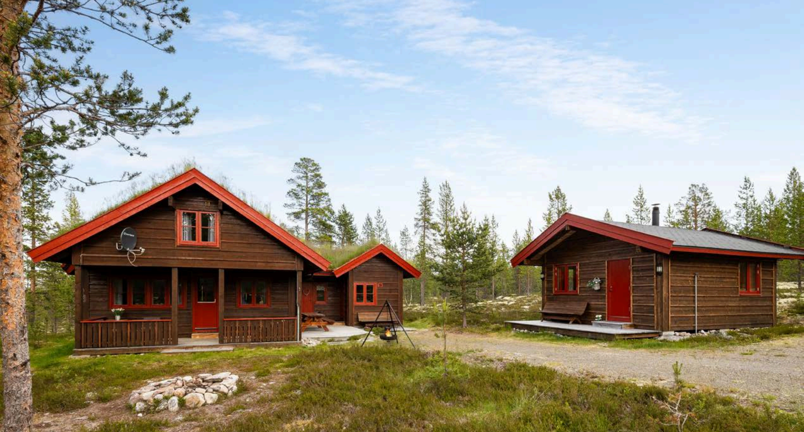
På eiendommen står det oppført et annekset som ble bygd i ca. 2016. Annekset har et stort rom innredet som soverom/stue, med en eldre vedkomfyr.
