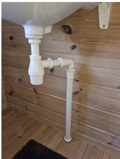
Bilde viser avløpsrør på rom benyttet som bad.
