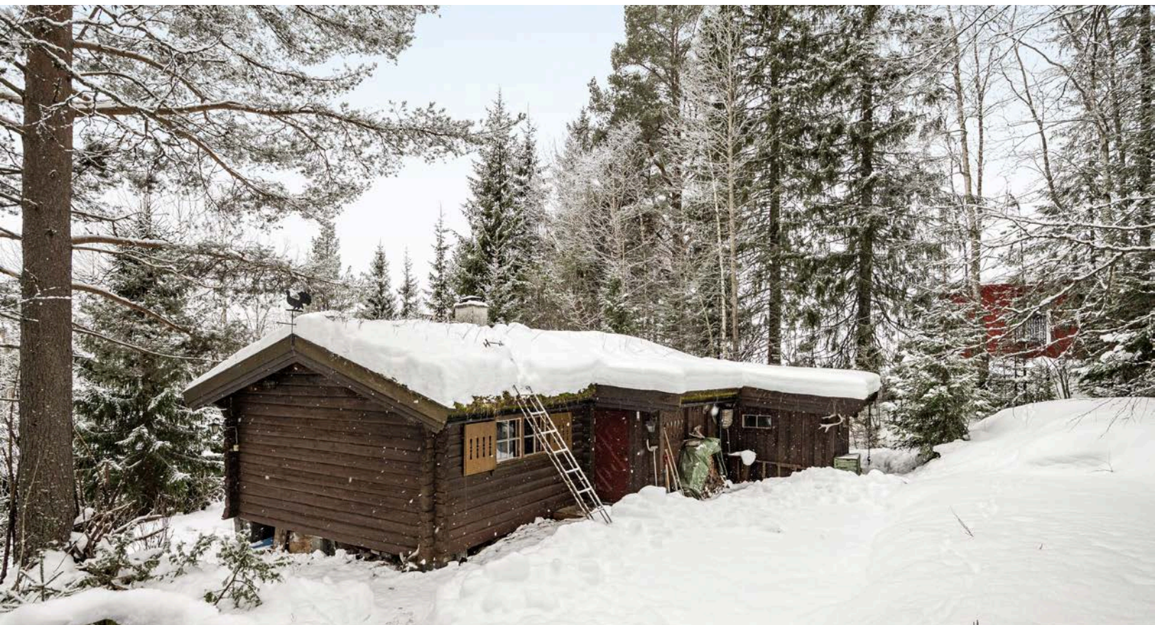
Opprinnelig del av hytta har yttervegger av 6" høvlet og laftet tømmer. Tilbygget del er utført av isolerte bindingsverksvegger, med stående panel innvendig og utvendig.
