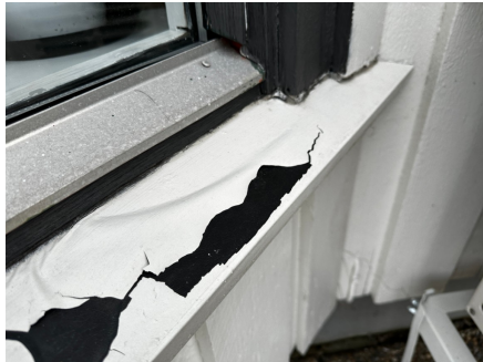
Avflassing på vindusbeslag
