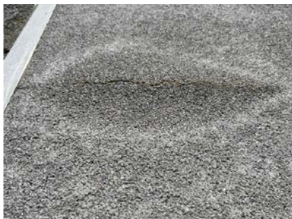
Utetthet tettesjikt over garasje
