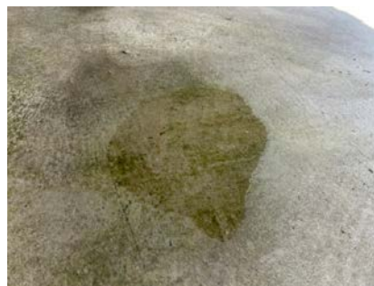
Fukt/vannspeil på gulv under befaring
