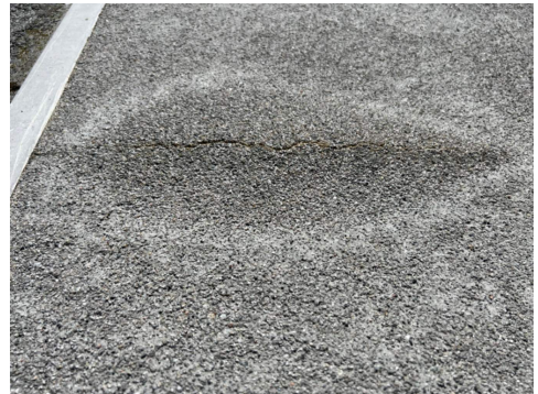
Utetthet tettesjikt over garasje
