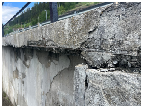
Forvitring og deformasjon av mur
