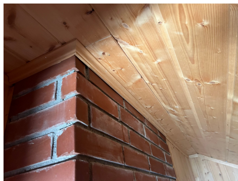
Brennbart material er inntil skorstein
