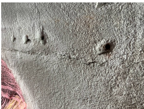
Sprekkdannelse på yttermur
