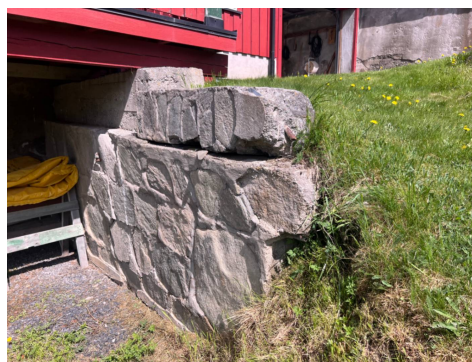
Forvitring og deformasjon av mur
