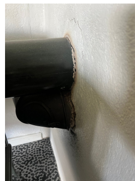
Brennbart material er inntil skorstein
